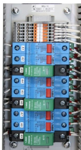
Модуль кроссовый МКр-14 (модуль грозозащиты для трех каналов, первый класс защиты)
